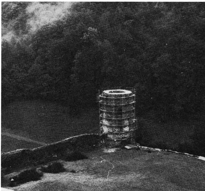
Der runde Turm eingerüstet.
