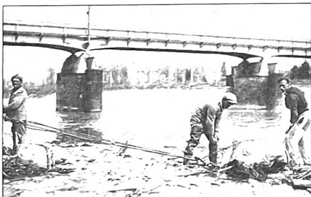
Willkommene Arbeit Ende der Vierziger- und Anfang der Fünfzigerjahre: Dank einer Vereinbarung der Ortsgemeinde Bad Ragaz mit der Rheinbaukorrektur konnten einheimische Fuhrunternehmer und Handwerker das Rheinwehr erstellen. (Quelle: Archiv Johann Egger und Peter Bonderer)
